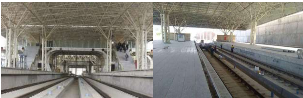
تصاویر پیشرفت پروژه قطار برقی شهر جدید هشتگرد
