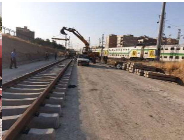
تصاویر عملیات اتصال شانت و عملیات بالاستریزی
