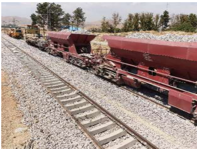
تصاویر عملیات اتصال شانت و عملیات بالاستریزی
