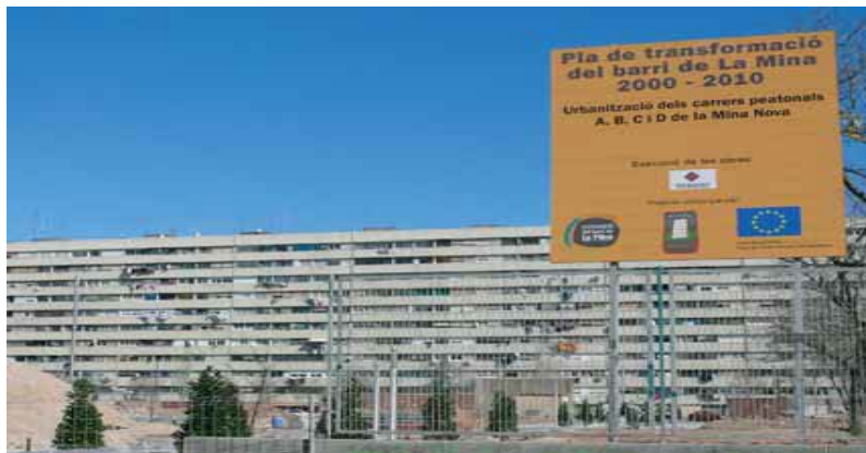
تصویر ۲-۵: مجموعه مسکونی بزرگ La Mina در زمان ساخت (بخشی از پروژه)
