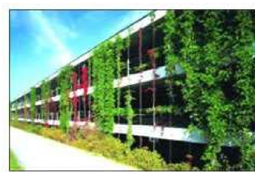
شکل (۱۱) دیوار سبز
